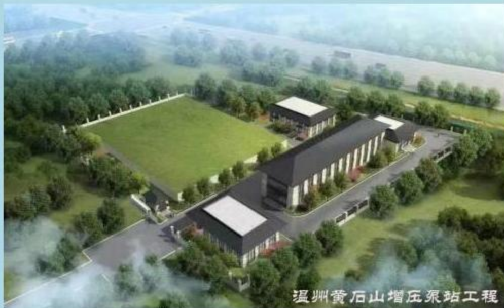
温州黄石山增压泵站工程-2023瓯江杯
