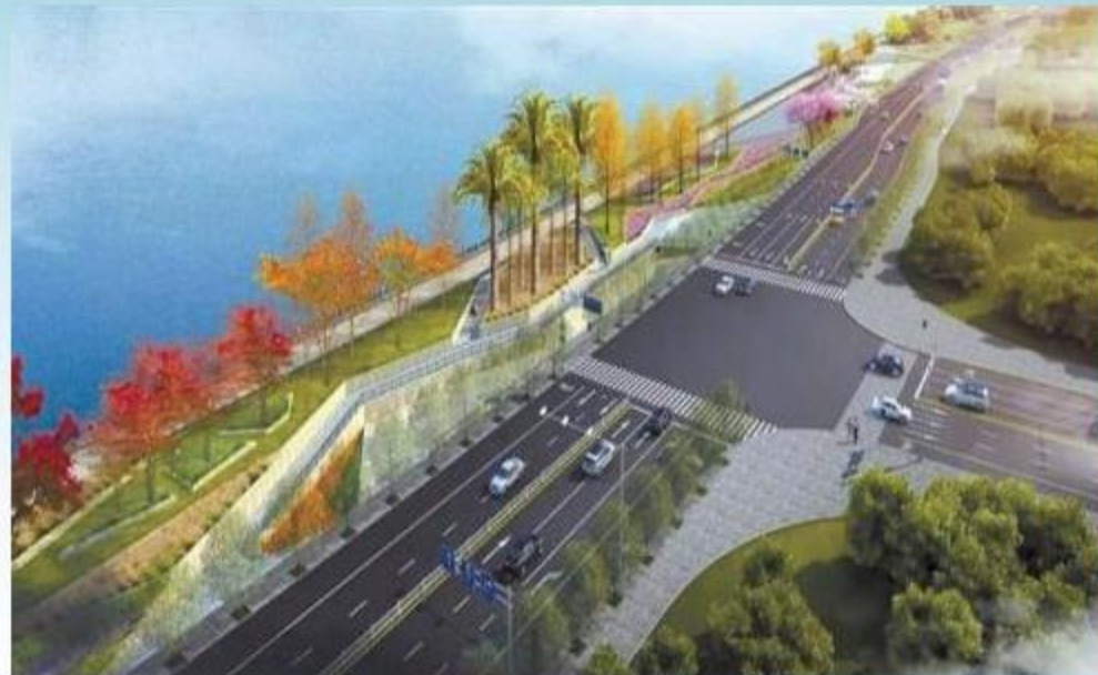
瓯江路东延及耐宝路延伸道路工程
