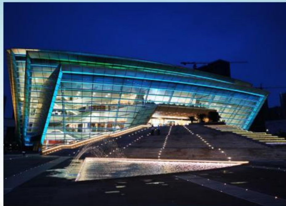
温州大剧院装修工程
