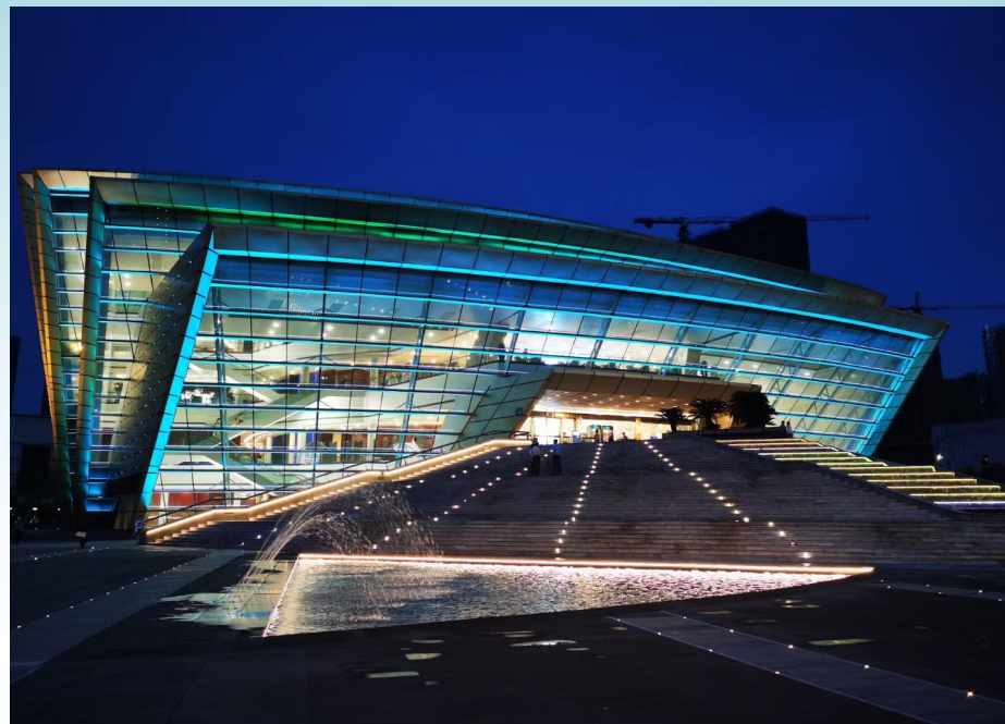
温州大剧院装修工程
